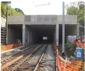
La mise à 4 voies de la ligne RER élargit la vallée entre le Collège et la plaine du Bois des Rêves. Les transformations nécessitent la construction d'un « pertuis » de 250 mètres, recouvert d'une dalle de prairie « pauvre ».
